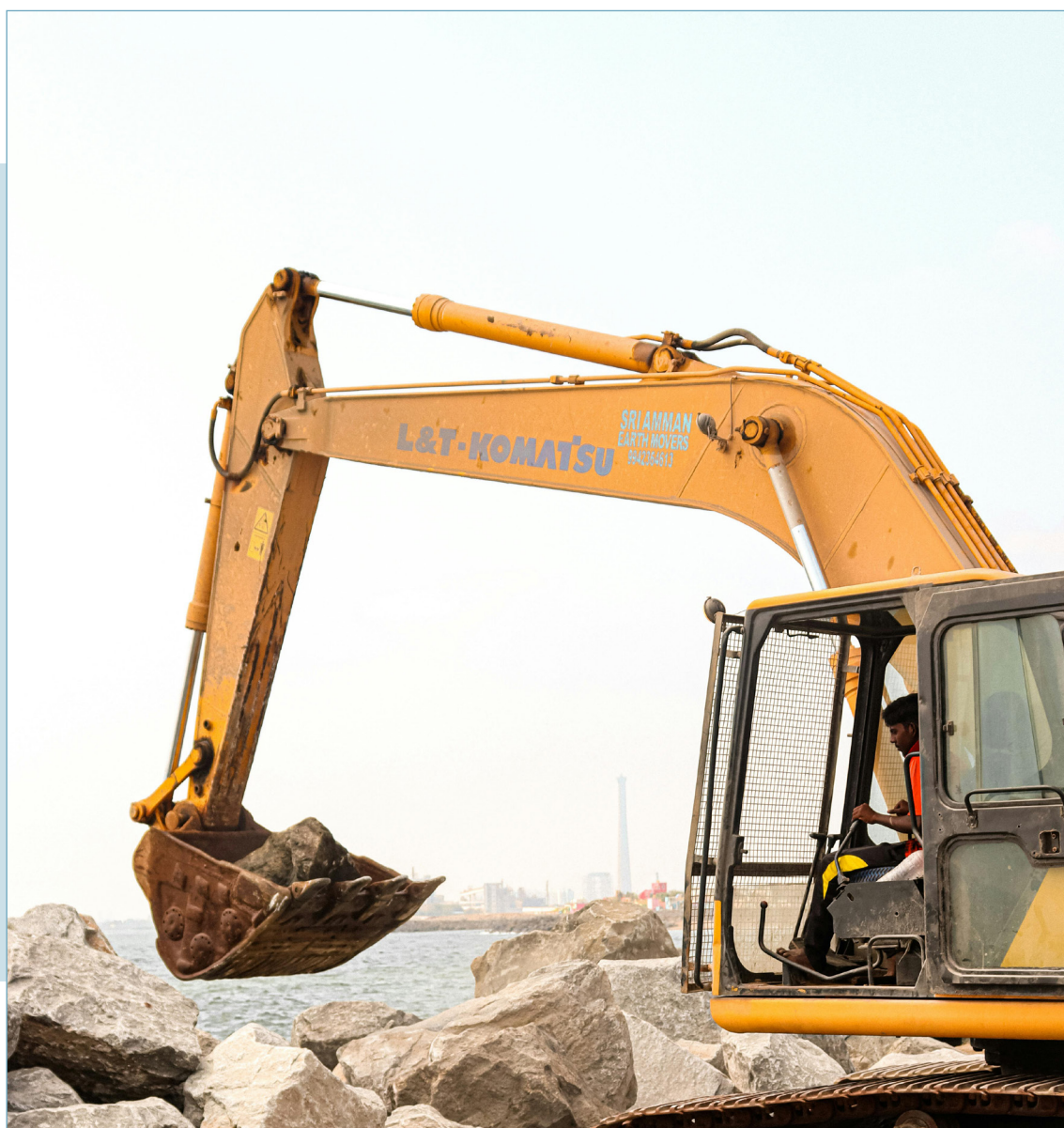
Figura 3 - Máquina escavadeira hidráulica
